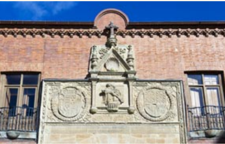
Façade of the Hospital de la Piedad. Detail
